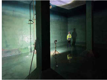
<내부 개별부재 외관조사>
