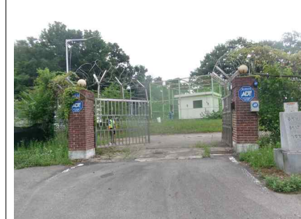
<진입로 포장 현황>
