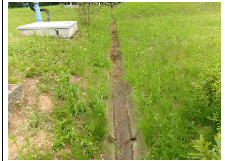
<부대시설 배수로 전경>
