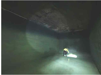
<내부 개별부재 외관조사>
