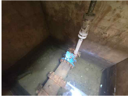
<유입밸브실(1지) 바닥슬래브 채수>
