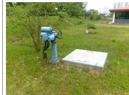
<환기구 등의 덮개(장비 반입구) 현황>
