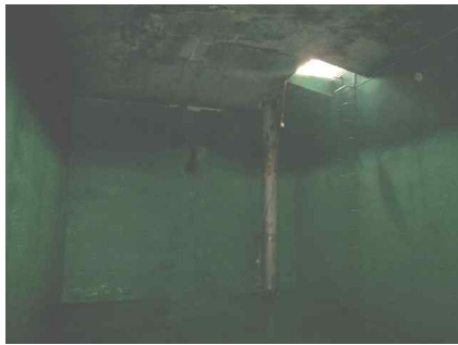
<배수지 1지 전경>
