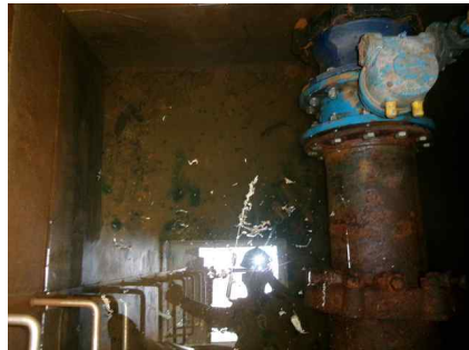
<유입밸브실(2지) 바닥슬래브 채수>
