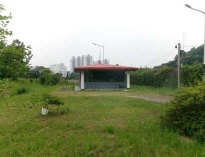
<부대시설 안전휀스 전경>
