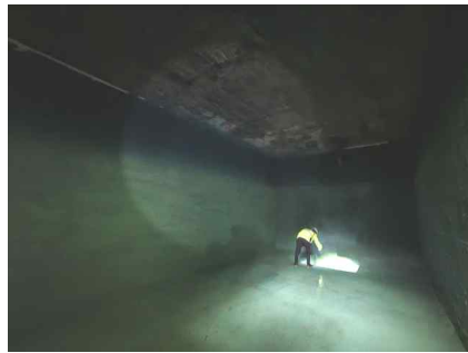
<배수지 2지 전경>
